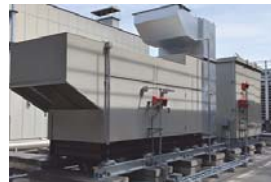
非常用発電機の増設 (NBF渋谷ガーデンフロント)
